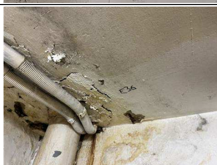
Photo n° 36 Localisation : Sous-sol : Archives 2 : Plafond Ouvrage : 4 - Plafonds et faux plafonds - Plafonds Partie d'ouvrage : Enduit à base de ciment lissé ou taloché Description : peinture + enduit cimenteux
