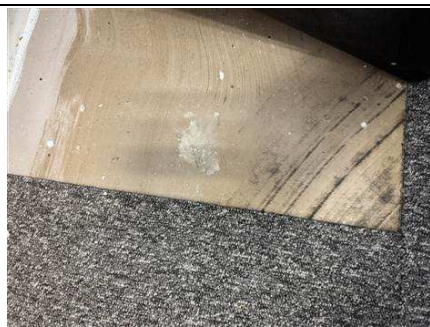
Photo n° 32 Localisation : RDC : Bureau - Sous moquette Ouvrage : 5 - Planchers et planchers techniques - Revêtements de sols Partie d'ouvrage : Colle non bitumineuse Description : Colle + ragréage
