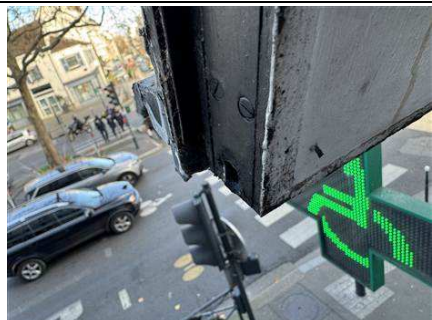
Photo n° 17 Localisation : R+1 : Juge de proximité - Fenêtre Ouvrage : 2 - Parois verticales extérieures et Façades - Menuiseries extérieures Partie d'ouvrage : Joint d'étanchéité entre menuiserie et structure Description : Joint noir
