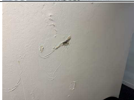
Photo n° 18 Localisation : R+1 : Salle attente - Mur Ouvrage : 3 - Parois verticales intérieures - Murs et cloisons maçonnés Partie d'ouvrage : Enduit à base de plâtre lissé ou taloché Description : Peinture + enduit plâtreux et cimenteux
