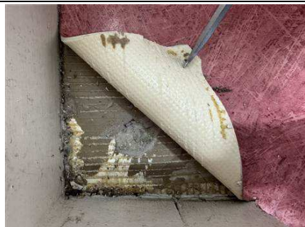
Photo n° 33 Localisation : RDC : Circulation 2 - Sous lino rouge Ouvrage : 5 - Planchers et planchers techniques - Revêtements de sols Partie d'ouvrage : Colle non bitumineuse Description : Colle + ragréage
