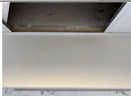
Photo n° 19 Localisation : R+1 : Box confidentialité - Linteau Ouvrage : 3 - Parois verticales intérieures - Murs et cloisons maçonnés Partie d'ouvrage : Enduit à base de plâtre lissé ou taloché Description : Peinture + enduit plâtreux
