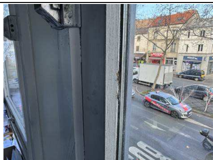
Photo n° 16 Localisation : R+1 : Juge de proximité - Fenêtre Ouvrage : 2 - Parois verticales extérieures et Façades - Menuiseries extérieures Partie d'ouvrage : Joint de mastic de vitrage (notamment châssis aluminium) Description : Mastic beige
