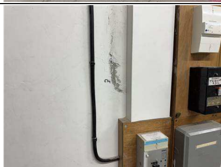
Photo n° 34 Localisation : Sous-sol : Circulation 1 : Mur Ouvrage : 3 - Parois verticales intérieures - Murs et cloisons maçonnés Partie d'ouvrage : Enduit de ragréage, débullage, lissage Description : Peinture + enduit de lissage
